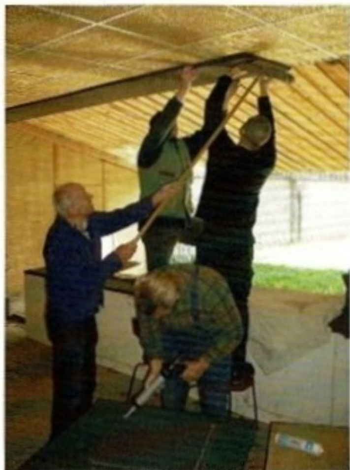
Renovierungsarbeiten am 50m Stand
